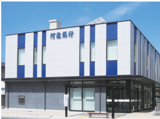
二軒屋支店(2019年5月27日新築オープン)
