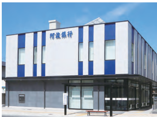
二軒屋支店(2019年5月27日新築オープン)
