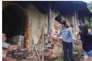
高低差6メートルの斜面に造られた、全長約28メートルの登り窯
